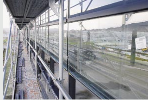
Glanzvoll: Die verglaste Fassade der Haupttribüne, in der sich die Autobahn spiegelt.
