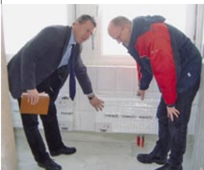
Fachplaner Lembke (rechts) und Kermi-Produktberater Carsten Hänsel prüfen es nach: Obwohl während der Umbauphase noch eingepackt und unter minimaler Teillast laufend, geben die Therm X2-Flachheizkörper schon jetzt ihre Wärme angenehm gleichmässig ab.
