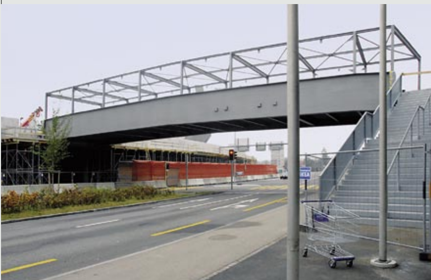
Erschlossen: Bereits ist die dritte von insgesamt vier Fussgänger-Überführungen vollendet.
