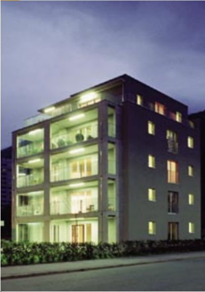
Das MINERGIE-P-Mehrfamilienhaus in Chur.
