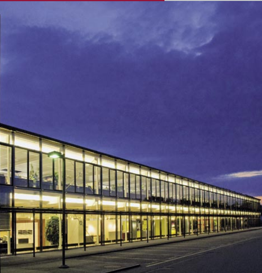
Ausstellung Forster Küchenzentrum Arbon «by night».
