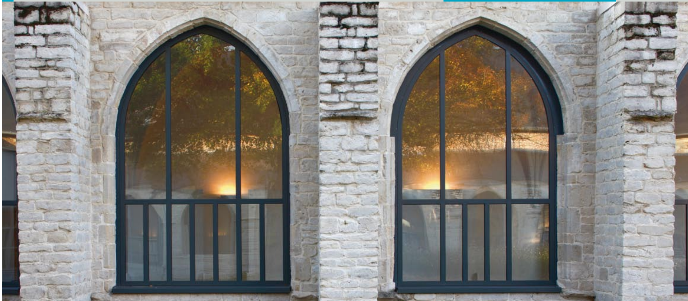
Wärmedämmte Fenster im Celestijnenkloster in Heverlee, Belgien.
