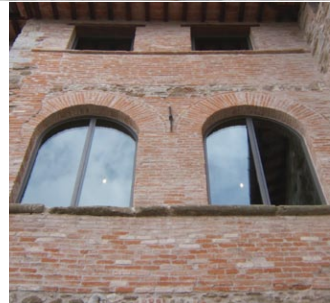
Das Castello in Civitella dei Conti in San Venanzo, Italien, fachmännisch restauriert mit schlanken Forster-Profilen.
