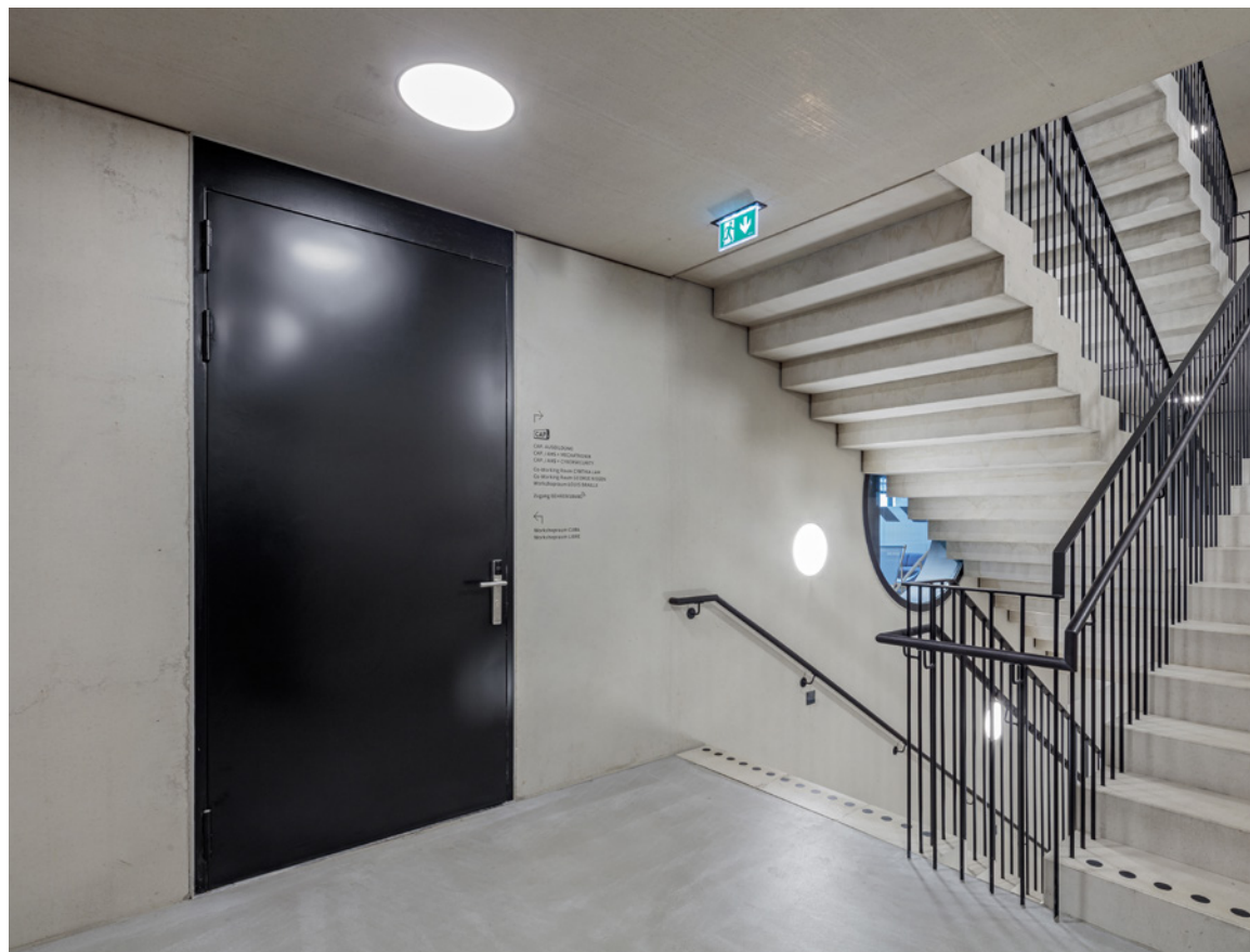
forster fuego light flächenbündig verblechte Brandschutztür, Tabakfabrik Linz, Österreich Bild: Martin Steinkellner
