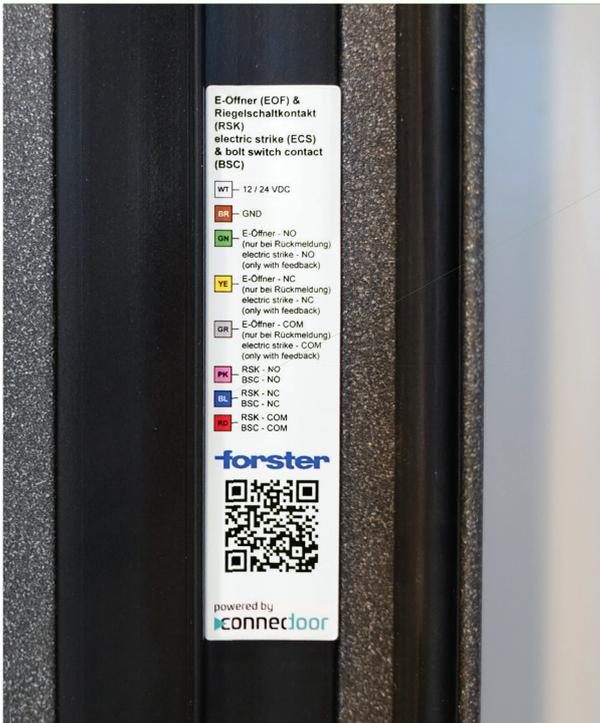
Étiquette avec schéma de raccordement: une interface sans demande de renseignements pour les corps de métier suivants
